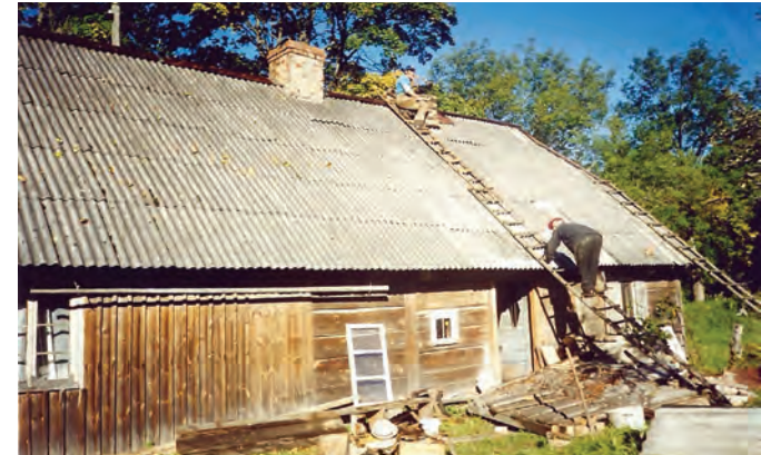
“Zvanītāju” remonts – bojātais šindeļu jumts tiek nomainīts pret šifera jumtu. 2000. gads.
